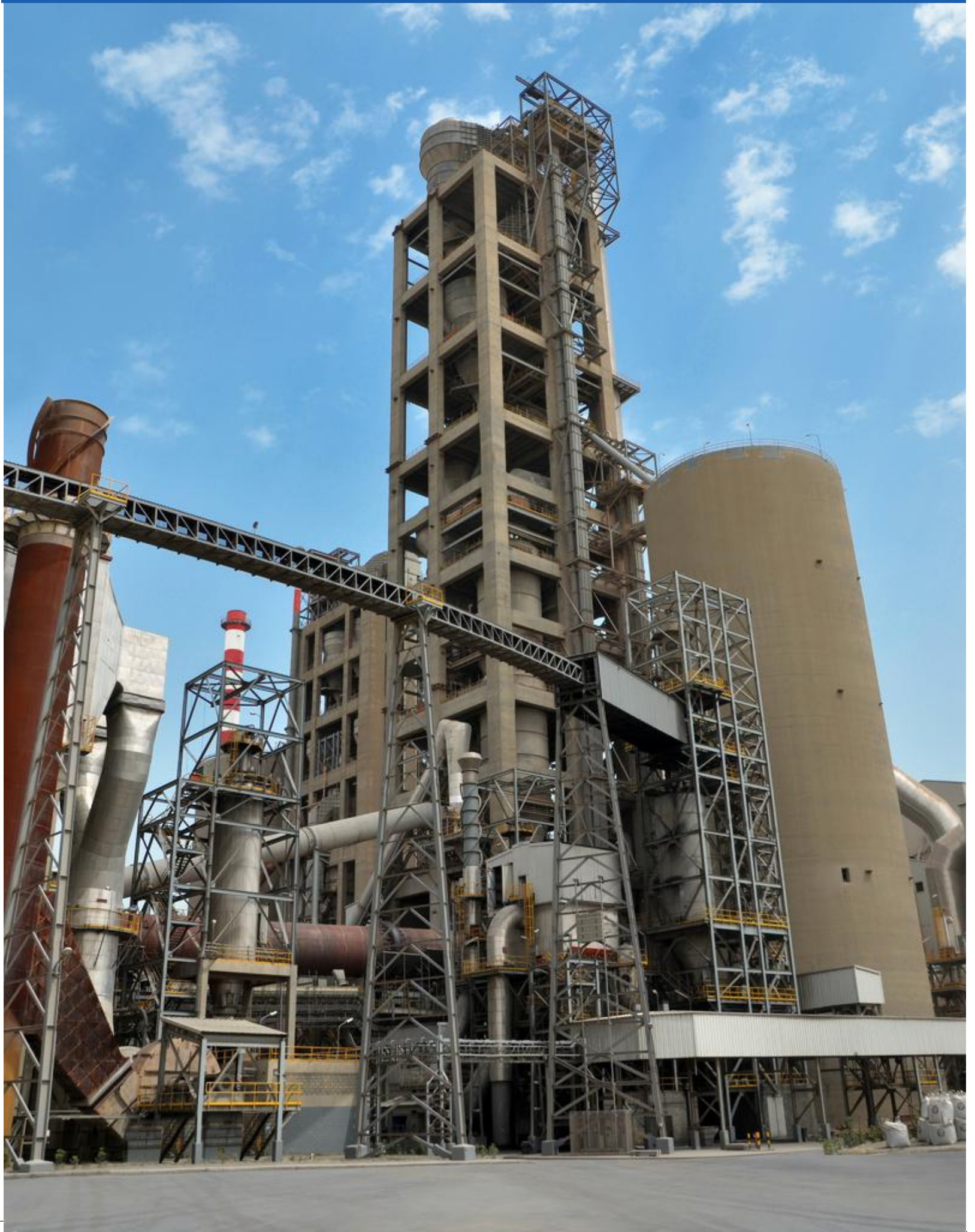
منظر جانبي لخط نقل الفحم الحجري وجهاز مرسب الإلكتروستاتيكي لمبرد الكلنكر
